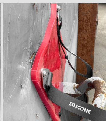
Záplata dokonale kopíruje nerovnosti povrchu poškozeného objektu
