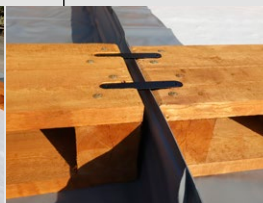
Detail der Verankerung der Holzrampe
