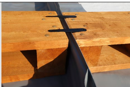
Detail ukotvení dřevěné rampy
