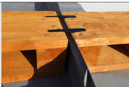
Detail ukotvení dřevěné rampy
